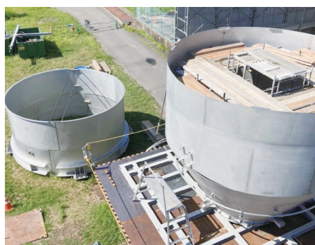
大阪府大阪市 柴島浄水場 水処理設備工事 (タンク設計はメーカー様)
